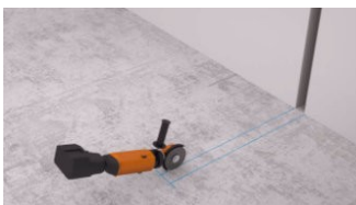
2. Vytvorenie drážky pre vodiče a chráničku podlahového snímača.
