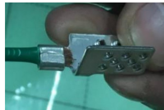
3. Zalisovanie vodiča do NK konektora.
